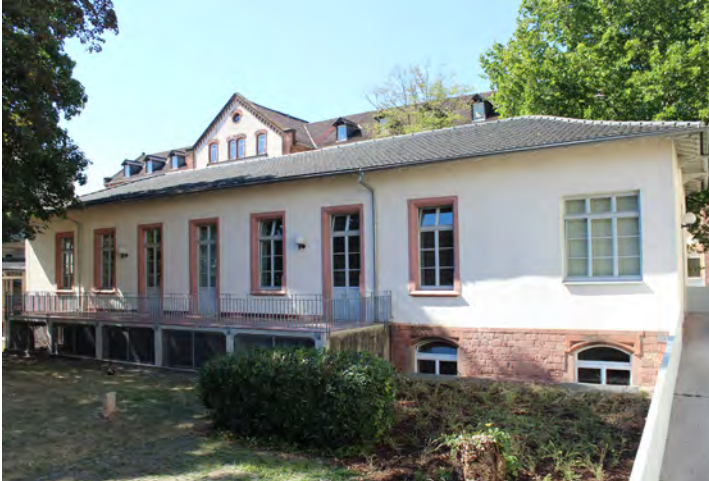
Standort Voßstraße 2, Gebäude 4330
